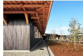
広島県立大崎海星高等学校 管理棟
