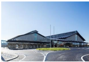
松江市総合体育館
