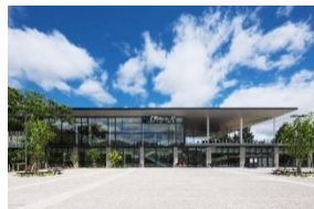
仙台市地下鉄東西線国際センター駅・ 青葉の風テラス
